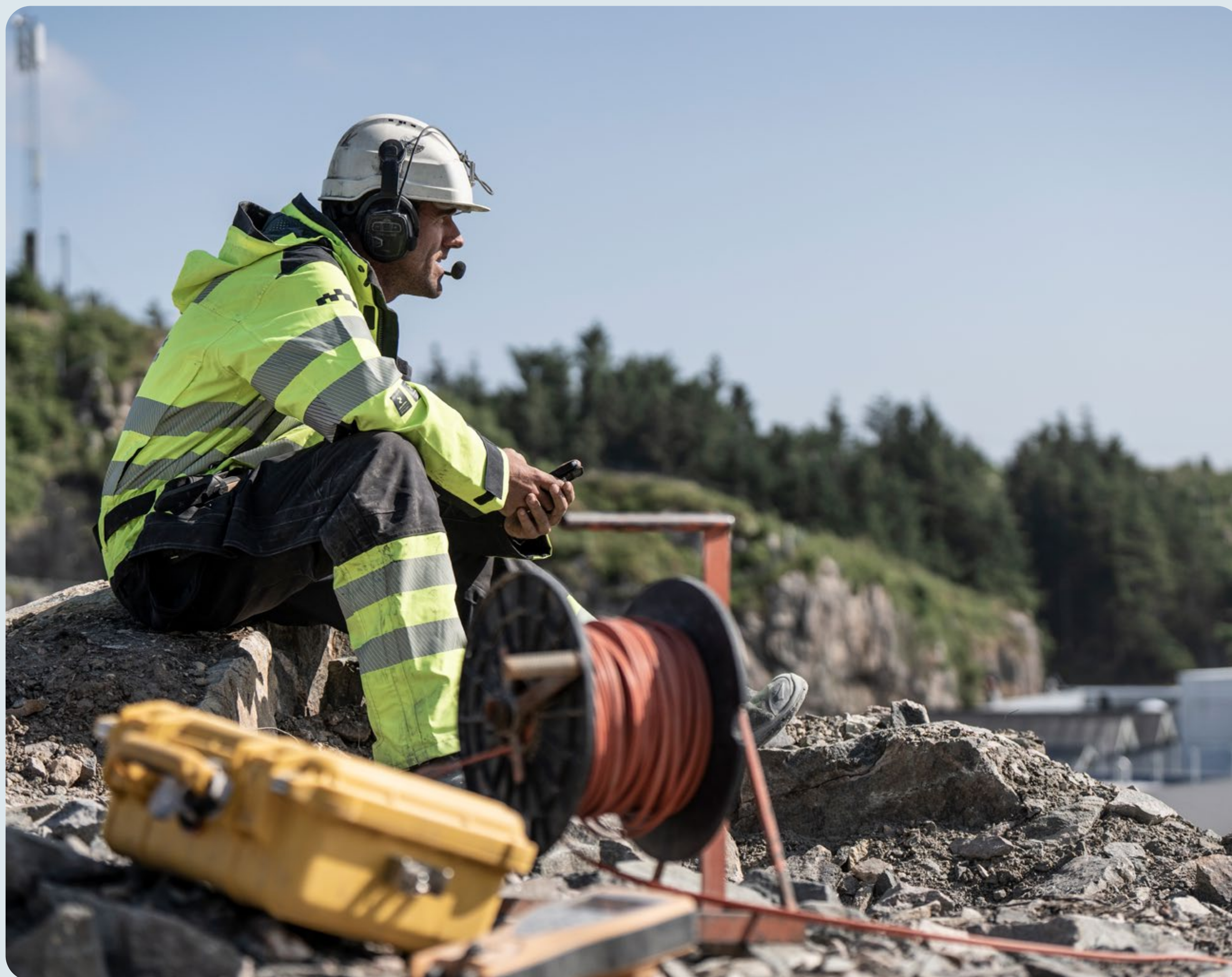
Christoffer Landmark frå Landmark Maskin sprenger vekk fjell og lagar klar ny industritomt i Kvednavikjo
